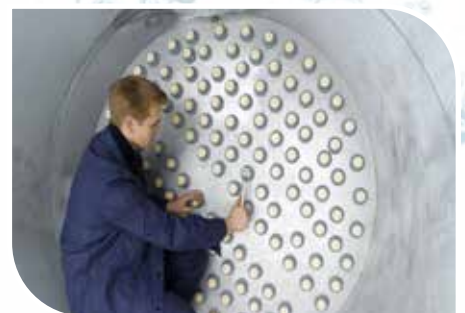
Düsenboden mit vielen Rückspühdüsen
